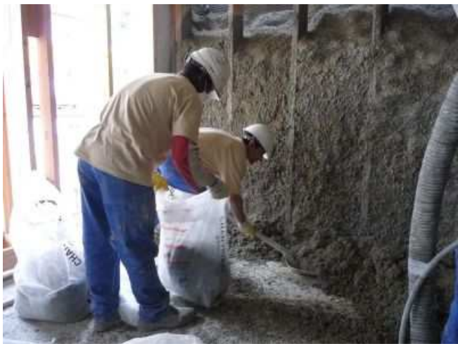
Les résidus issus de la projection sont ensuite ramassés et réinjectés dans le cycle du matériau. Recyclage garanti.
