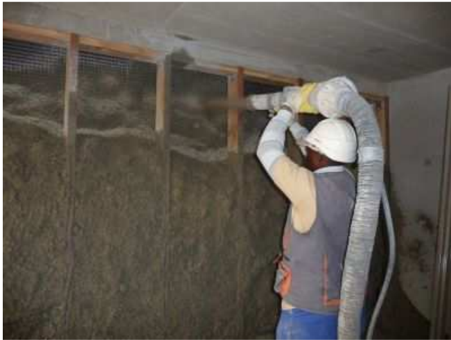
Ici, un des ouvriers du chantier procède au remplissage d'une paroi par projection de béton de chanvre.
