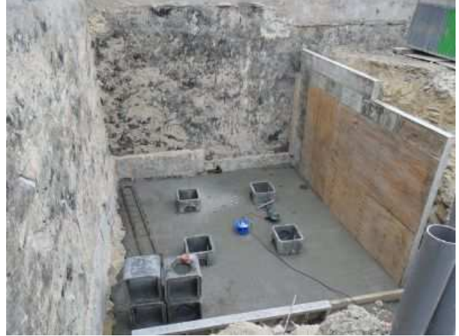
Les planchers et plafonds sont en béton armé.
