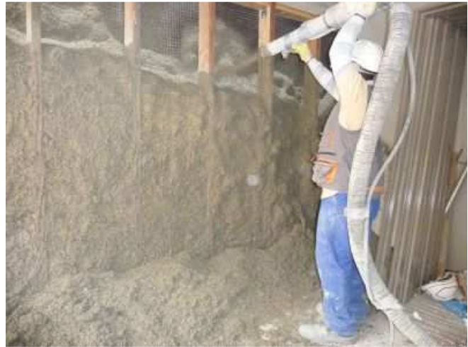
Ici, un des ouvriers du chantier procède au remplissage d'une paroi par projection de béton de chanvre.
