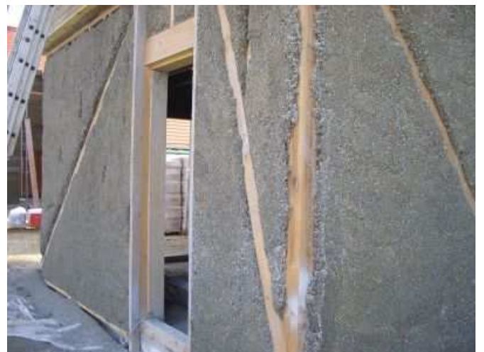
Le béton de chanvre possède une inertie que n'a pas le bois.
