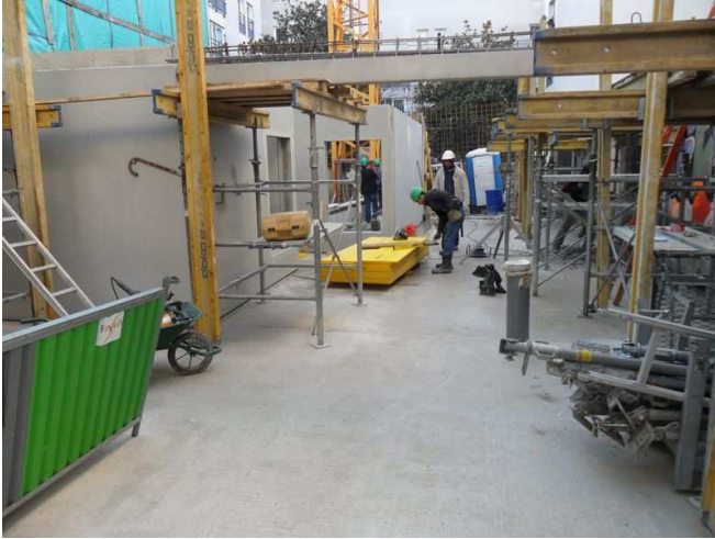
Le bâtiment comporte avant tout une structure porteuse en béton armé.
