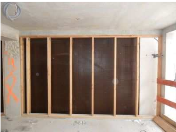
Le béton de chanvre qui remplit la structure bois assure également une isolation phonique et acoustique des parois. La projection continue des parois engendre la réduction des ponts thermiques, puisqu'elle joue le rôle d'isolation par l'extérieur.
